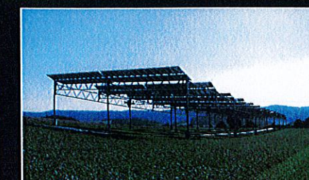
Les ombrières agrivoltaïques fixes
