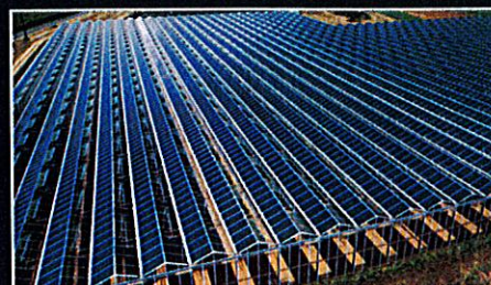
Les serres photovoltaïques
