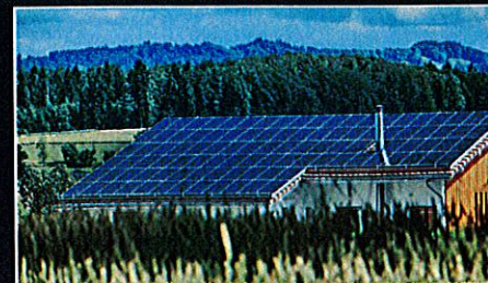
Les bâtiments agricoles équipés d'une toiture solaire
